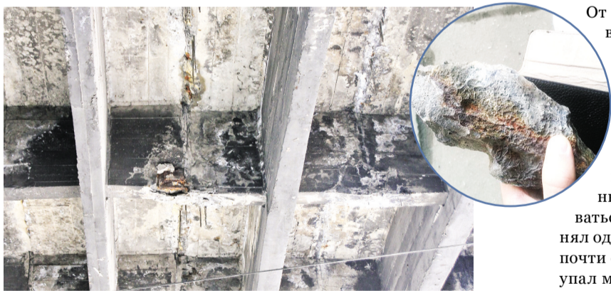
▲ От моста 850-летия отламываются куски бетона
